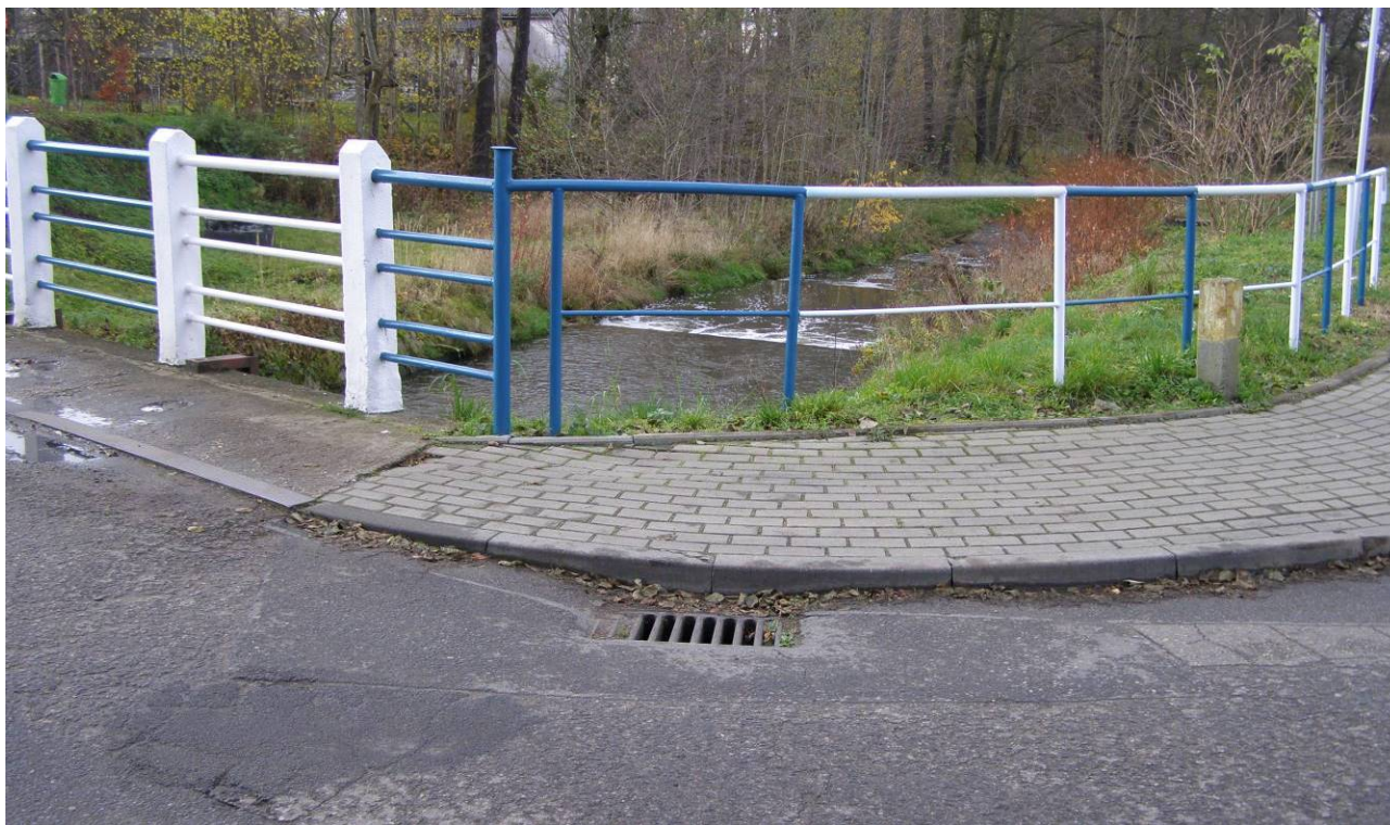
Fot. 7. Nieprawidłowe zabezpieczenie jezdni na dojeździe, deformacje balustrady, ubytki i uskoki nawierzchni na połączeniu z obiektem, nieprawidłowe odprowadzenie wody z obiektu do wpustu – zastoiska wody na płycie, zapadnięcie studzienki przy wpuszczeniu – niedostateczne prace utrzymaniowe i naprawcze, nieprawidłowo ukształtowana niweleta
