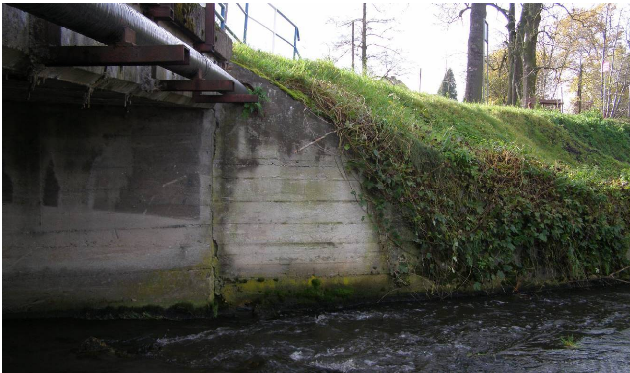
Fot. 14. Wysolenia i ubytki betonu skrzydła, silna wegetacja roślinności na skrzydle, degradacja biologiczna i mechaniczna betonu od wrastających korzeni,
