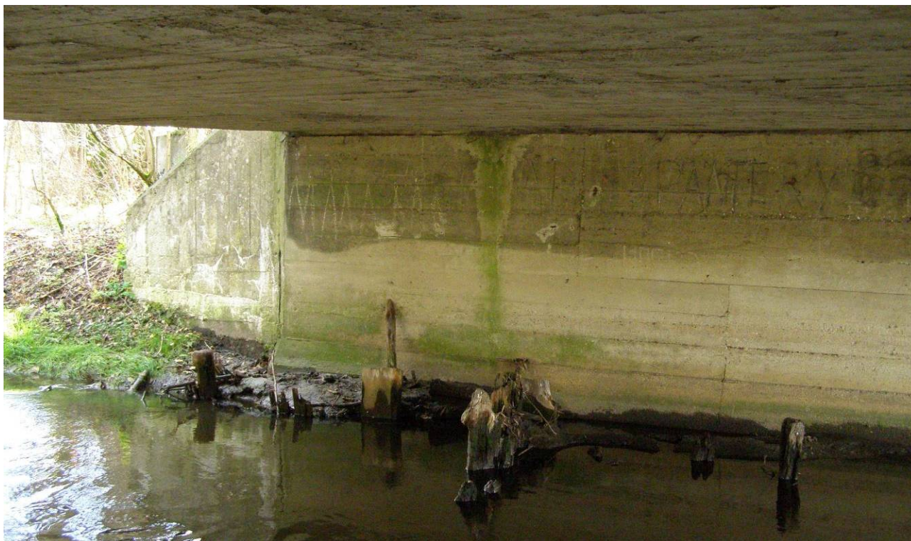
Fot. 18. Zniszczenie drewnianego umocnienia brzegów cieku pod obiektem, – erozja wodna, degradacja materiału, brak prac utrzymaniowych w cieku
