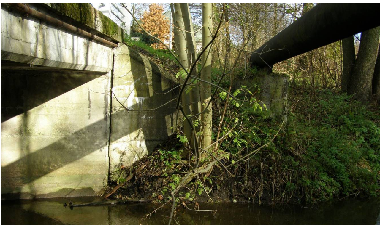
Fot. 17. Drzewo wrastające w skrzydło, podmycie skarpy stożka, wegetacja roślin na skrzydle – brak prac utrzymaniowych przy obiekcie i w korycie cieku, brak zabezpieczenia skarpy przed rozmyciem
