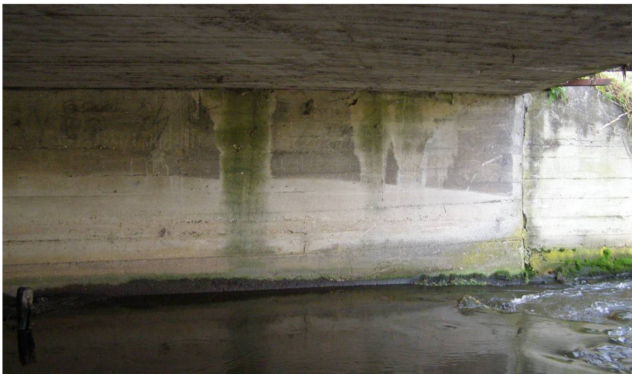
Fot. 12. Zacieki i wysolenia na korpusie przyczółka,
