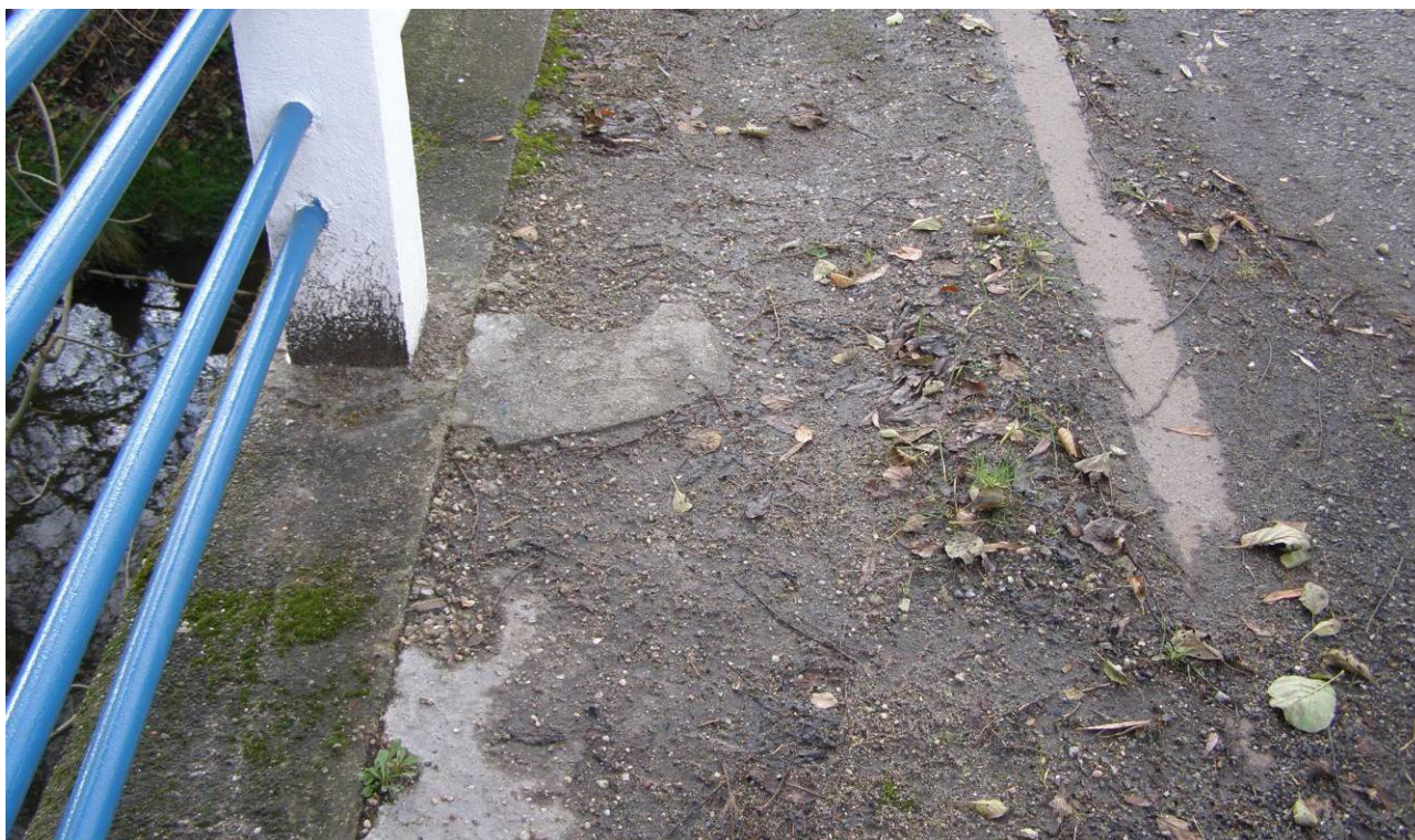
Fot. 8. Korozja i ubytki nawierzchni na kapach chodnikowych, zanieczyszczenie płyty pomostu, wegetacja roślin na obiekcie, – brak prac utrzymaniowych i naprawczych, niska jakość materiału
