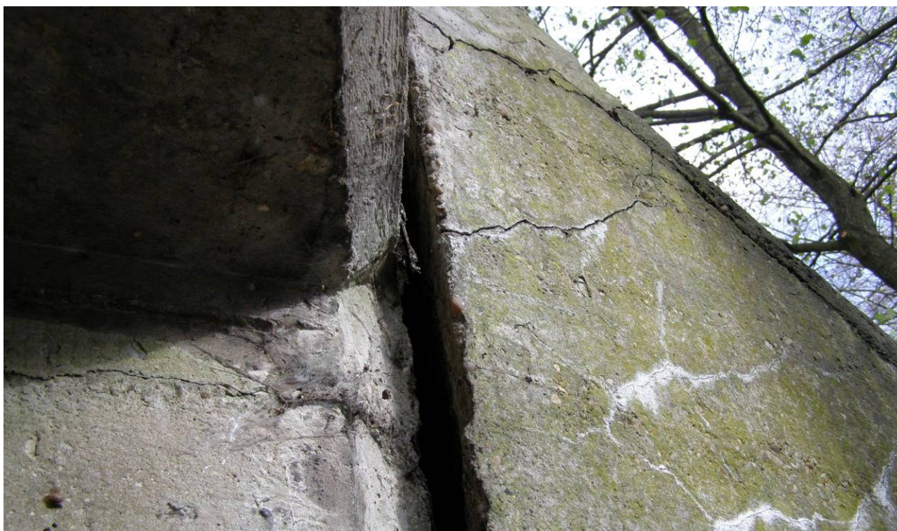
Fot. 15. Zarysowania i spękania skrzydła, wysolenia w miejscu spękań, przemieszczenie się korony skrzydła, brak wypełnienia dylatacji pomiędzy skrzydłem a korpusem przyczółka – wegetacja roślin za skrzydłem, brak izolacji odziemnej betonu,
