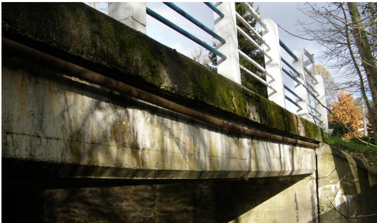
Fot. 9. Wegetacja roślin na gzymsie, wysolenia i zacieki na bocznej powierzchni dźwigara, ugięcie płyty przęsła od strony wody górnej, korozja i deformacja rury osłonowej instalacji obcej
