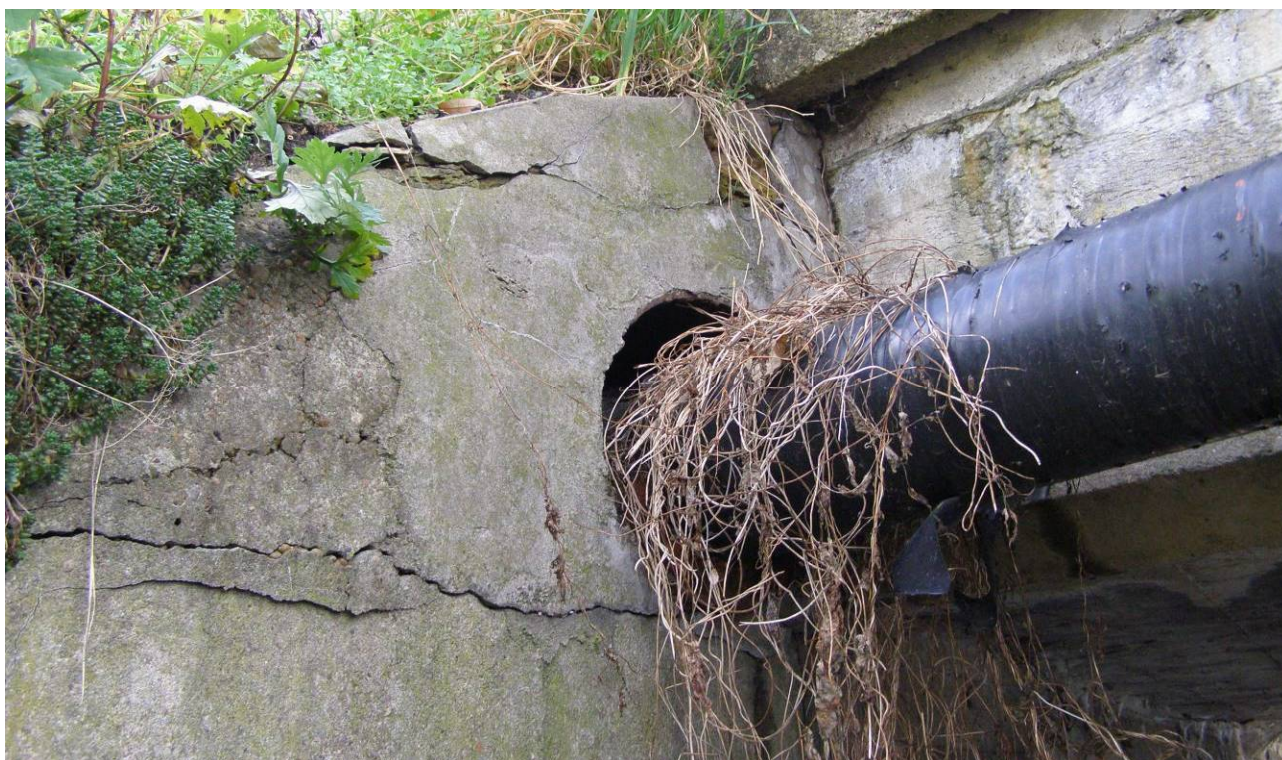
Fot. 20. Pęknięcia i odspojenia korpusu skrzydła w miejscu wlotu instalacji obcej, – brak prawidłowego zbrojenia korony skrzydła, silna wegetacja roślin za skrzydłem powodująca degradację materiału i rozpychanie zasypki
