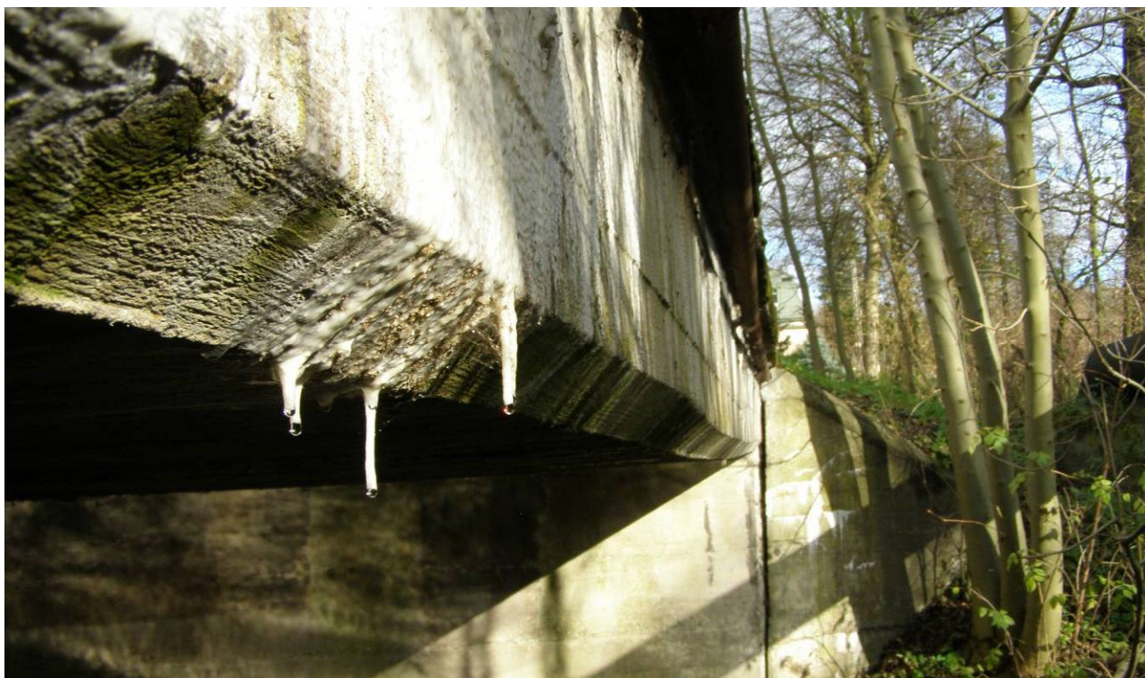
Fot. 10. Wysolenia i wykwity na bocznej powierzchni płyty, ugięcie płyty przęsła od strony wody górnej
