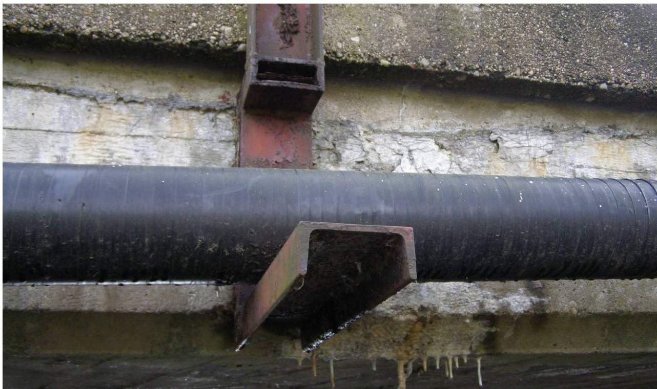
Fot. 19. Korozja powierzchniowa elementów podwieszenia instalacji obcej do obiektu – brak prac utrzymaniowych
