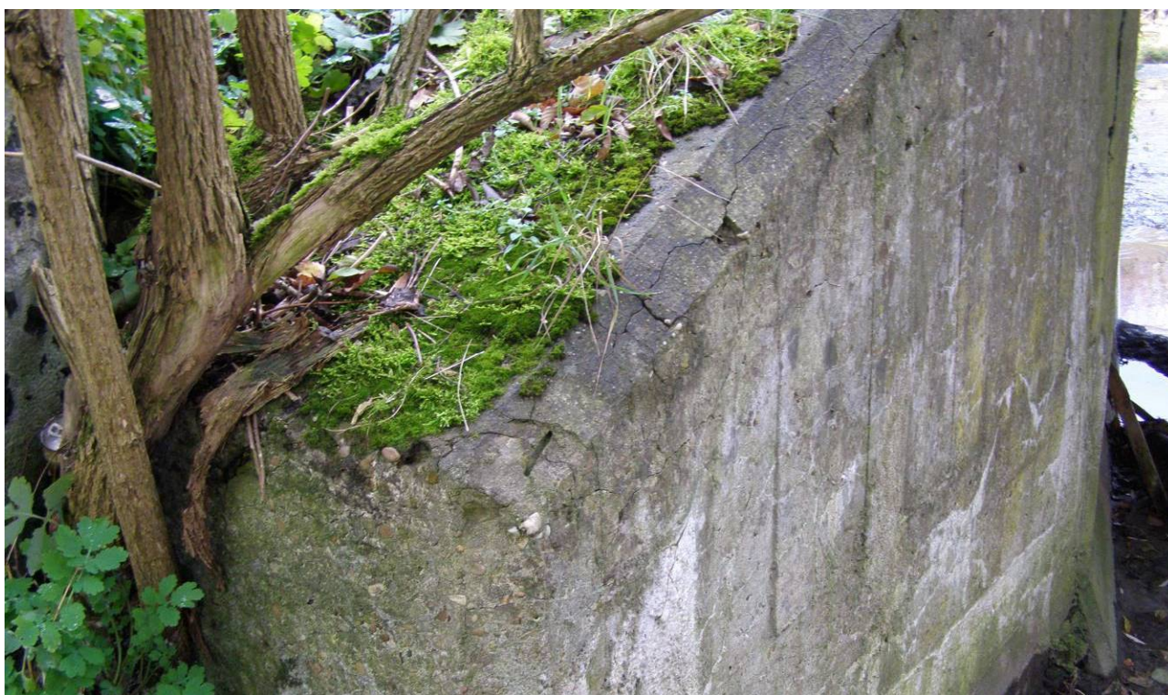
Fot. 16. Wysolenia i ubytki betonu skrzydła, silna wegetacja roślinności na skrzydle, degradacja biologiczna i mechaniczna betonu od wrastających korzeni, – brak prac utrzymaniowych
