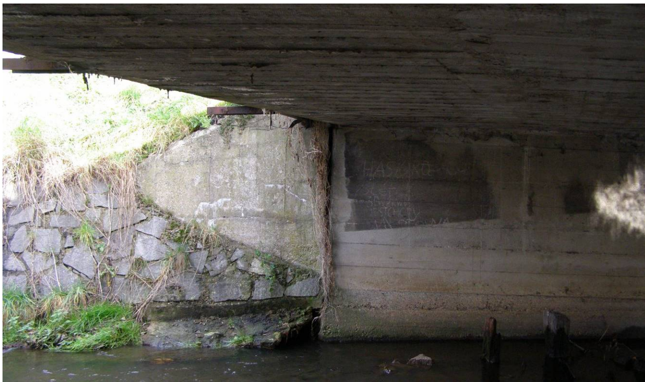
Fot. 13. Rysy, wysolenia i ubytki betonu skrzydła, ubytki spoin i materiału obruku skrzydła, podmycie umocnienia, wegetacja roślin na skrzydle i umocnieniu koryta
