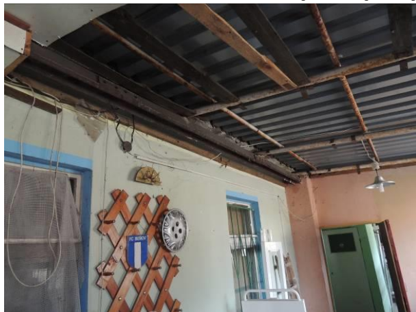
Fot. 12,13. Widok na stalową konstrukcję zadaszenia części dobudowanej budynku. Zadaszenie przeznaczone do rozbiórki.
