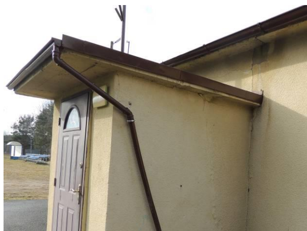
Fot. 8-11. Widoczne uszkodzenia elewacji w postaci pęknięć
