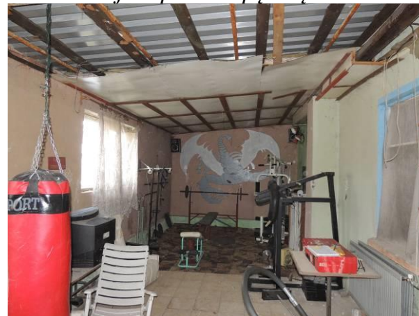
Fot. 12,13. Widok na stalową konstrukcję zadaszenia części dobudowanej budynku. Zadaszenie przeznaczone do rozbiórki.
