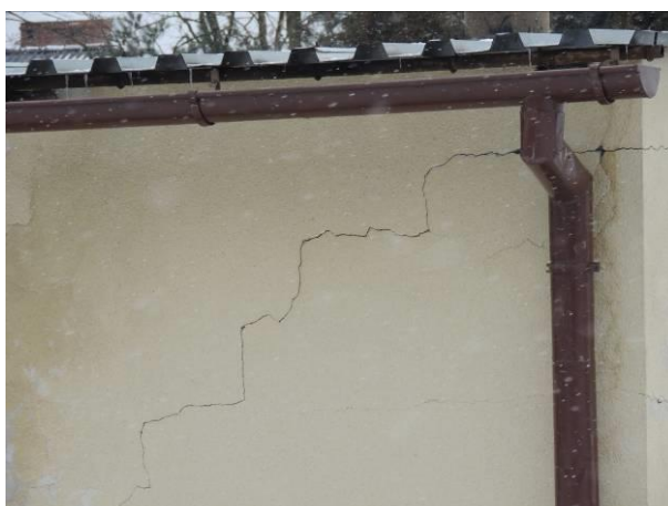
Fot. 8-11. Widoczne uszkodzenia elewacji w postaci pęknięć
